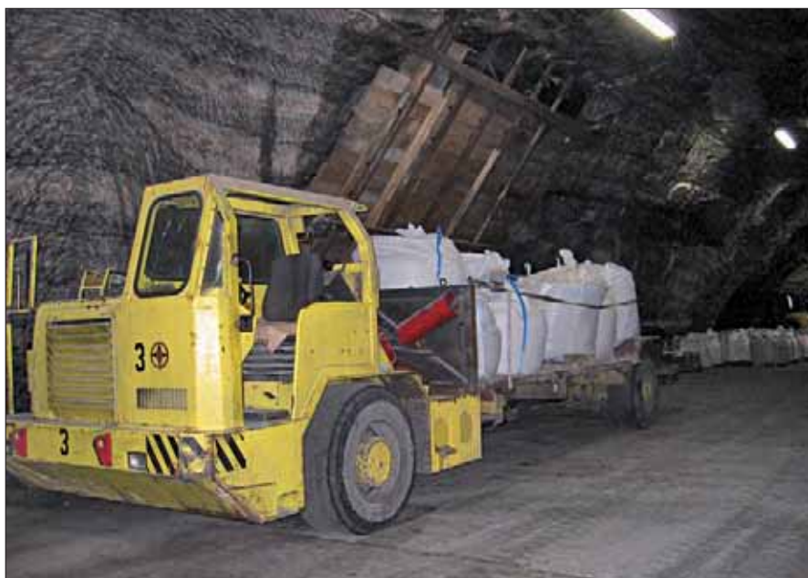
Abb. 2: Anlieferung von Big-Bags an den Einbauort (Foto: TLBA).
