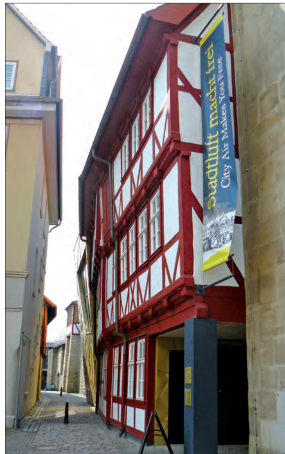
Blick in die Gasse nach Westen entlang des Ensembles bis zum Georgsturm.
