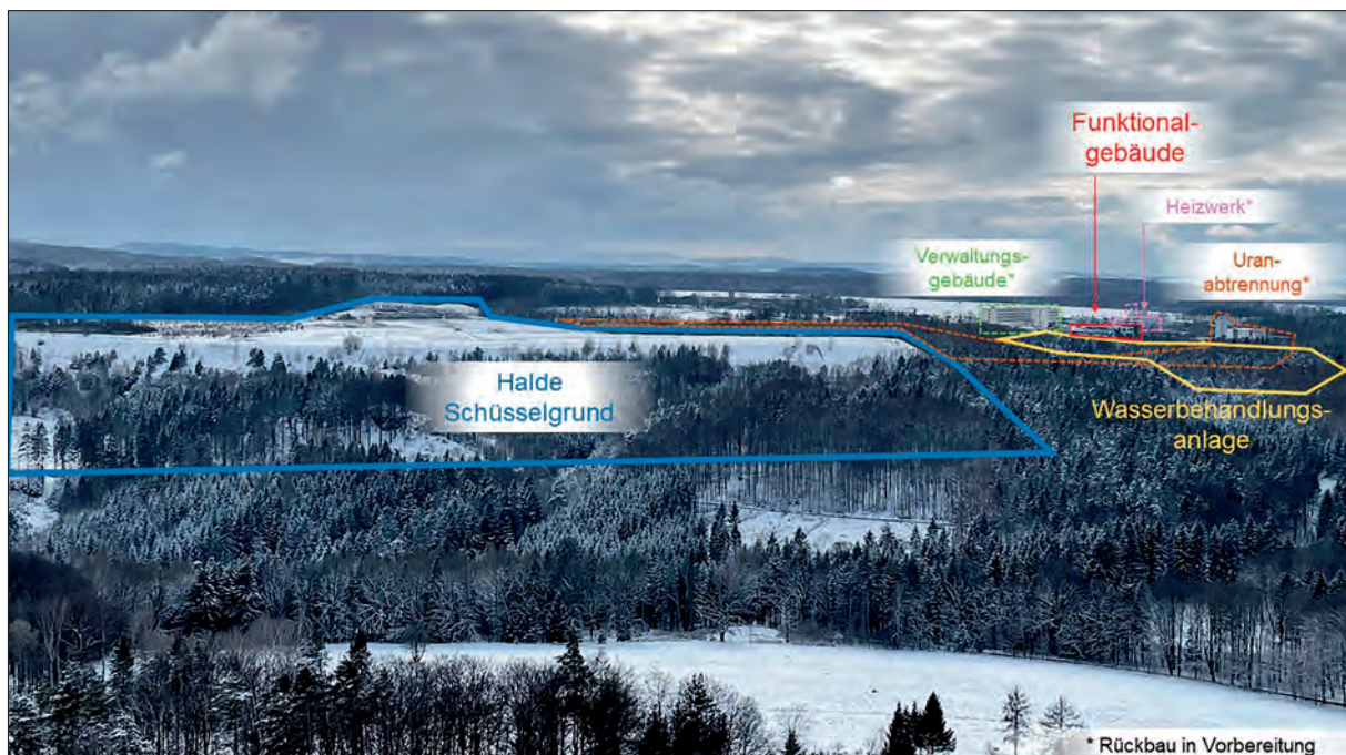
Abb. 1: Betriebsgelände Standort Königstein; Blick von Festung Königstein (2023)
