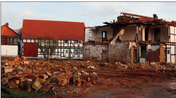
Abriß eines Fachwerkhauses im Ortseingangsbereich des Dorfes Elvershausen (Foto: Ulrich Harteisen 2014).
